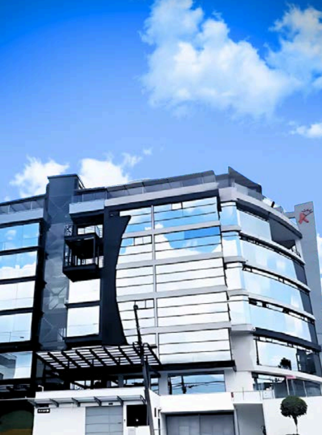
Foto: Edificio K+
